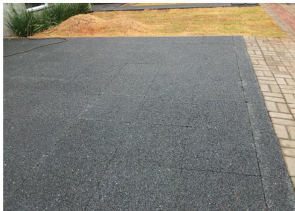
Piso Drenante 45x45 cm, na cor comercial Grafite, em construção, sendo aplicado em pátio, integrado a piso Inter travado.
