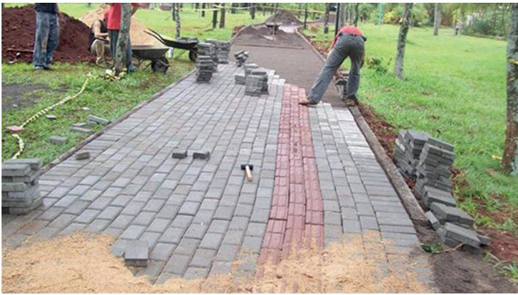
Piso Drenate em Paver 20x10x6 cm (tráfego médio) na cor Vinho Rustico com perfil de Direcional Podotátil NBR 9050, aplicado em acesso calçado com Paver Cinza Granito.
